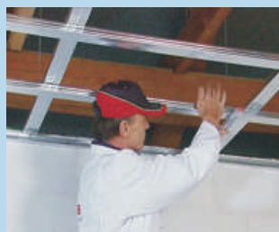
1 Postavimo metalnu podkonstrukciju
