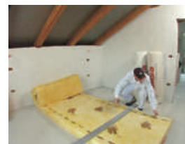
4. Izolaciju izrežemo na ploče odgovarajuće veličine
