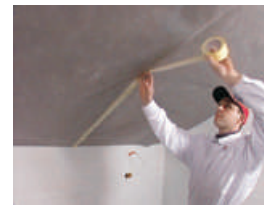
8. Svi spojevi, proboji i priključci na foliji moraju biti zalepljeni
