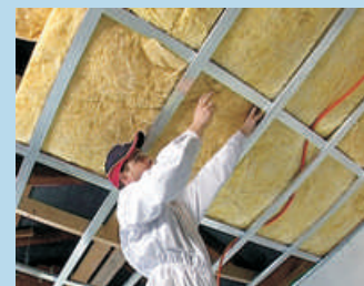
2 Postavimo prvi sloj toplotne izolacije
