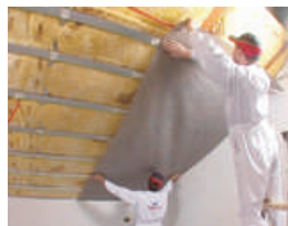
7. Na "C" profil sa dvostranom lepljivom trakom nalepimo parnu prepreku
