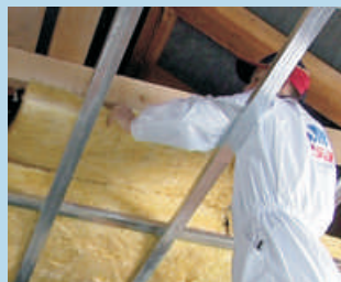
3 Postavimo drugi sloj toplotne izolacije
