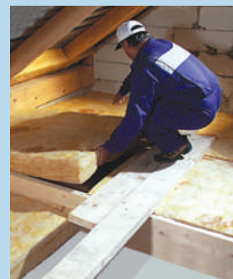
2 Postavimo drugi sloja izolacije. Kod rezanja na odgovarajuće dimenzije dodajte 2 cm
