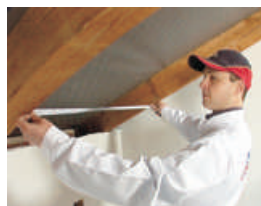
3. Kod merenja računamo 1 do 2 cm više zbog boljeg naleganja izolacije
