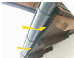
1. U okapnici moramo omogućiti dotok vazduha u krov
