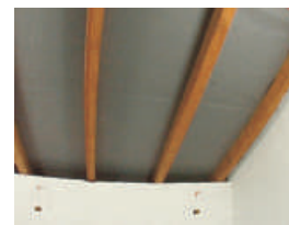
2. Postavimo paropropusnu-vodonepropusnu foliju
