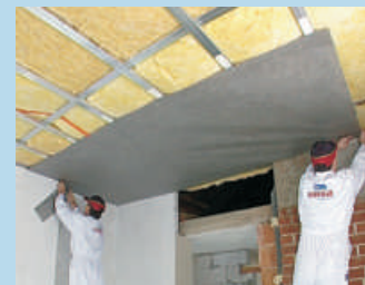
4 Postavimo zaštitnu foliju - parnu prepreku/branu
