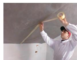
8. Svi spojevi, proboji i priključci na foliji moraju biti zatepljeni
