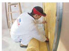
4 Prostor u potpunosti ispunimo vunom
