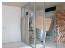
2 Postavimo gips-kartonske ploče
