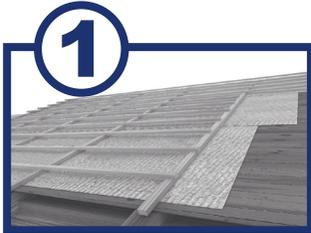
Membranu **Ursa** može se postaviti izravno na krovnu daščanu oplatu. Materijal je potrebno rastegnuti preko cijele površine krova.
