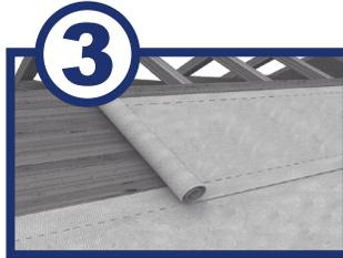
Prilikom postavljanja membrane **Ursa** potrebno je primjenjivati 15 cm preklapanja (mjesto preklapanja na membrani označeno je linijom). U slučaju kada je nagib krova manji od 22°, preklapanje mora iznositi najmanje 20 cm.
